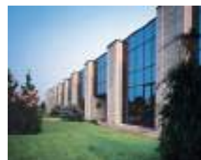
USINE DE PAVIE : IT COOLING
