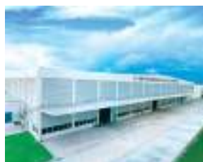
USINE DE CHONBURI EN TAÏLANDE
