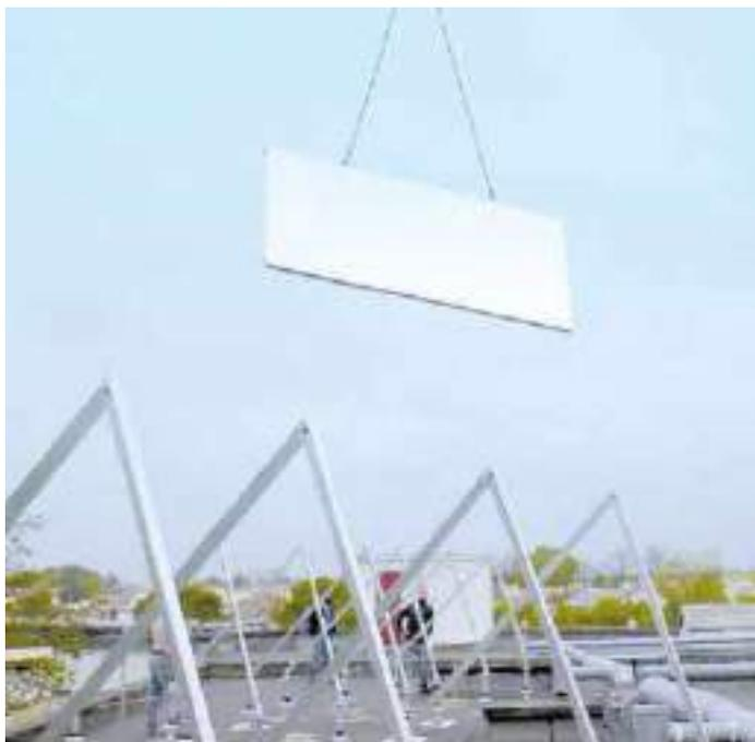
Être vigilant par rapport à la prise au vent des capteurs
