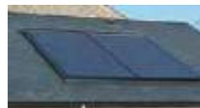
Capteurs intégrés au toit
