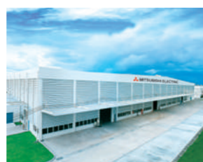
USINE DE CHONBURI EN TAÏLANDE
