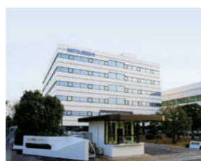
USINE DE SHIZUOKA AU JAPON
