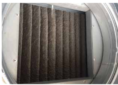
Exemple de filtre non remplacé au moment opportun
