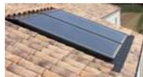
Capteurs intégrés au toit
