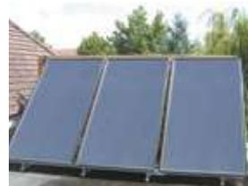
Capteurs sur châssis
