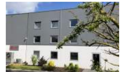
Usine de Feuquières-en-Vimeu
